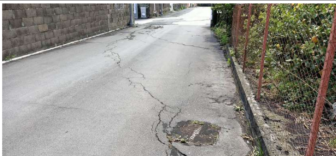
Foto 57 Effetti di Creep asismico lungo la Faglia di Casa Carpinati
