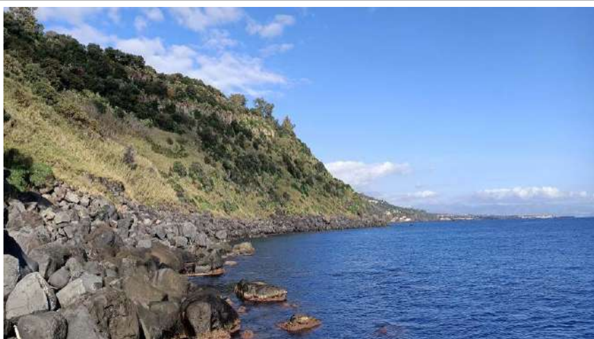
Foto 90: Linea di costa sotto la Timpa in zona Acque grandi
