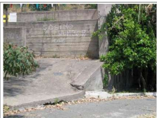
Foto 1 – Zona di frattura in corrispondenza di un muro di contenimento delimitante un campo da tennis all'interno del camping "Il Panorama" (Immagine del 20/06/2005).
