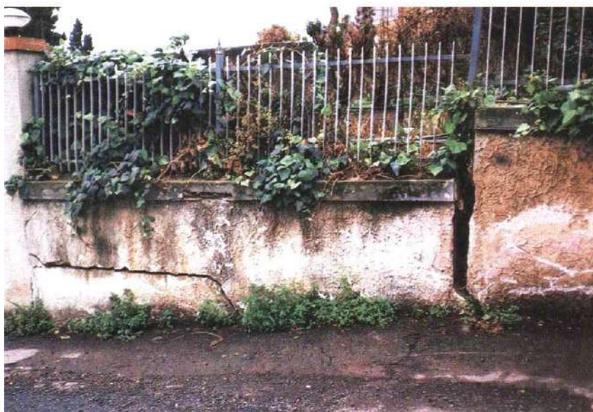
Figura 21 Foto zona di fratturazione della Faglia di Santa Tecla in SP per Riposto
