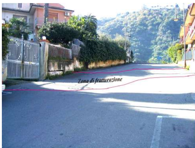
Foto 1: Zona di Fratturazione di via Cocole nella parte meridionale di Santa Tecla (immagine del 02/02/2004)
