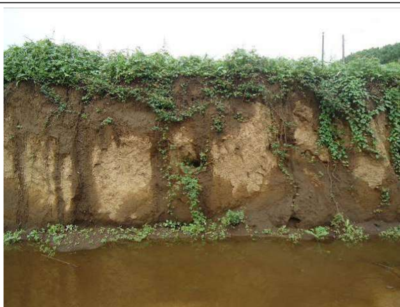
Foto 21 – Tufiti al top della scarpata della Timpa in zona Belfrontizio
