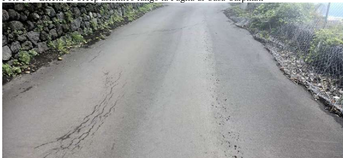
Foto 58 Effetti di Creep asismico lungo la Faglia di Casa Carpinati
