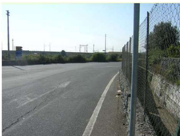
Fig. 4.3.22 – Opere idrauliche a margine della via S. Piero Patti.
