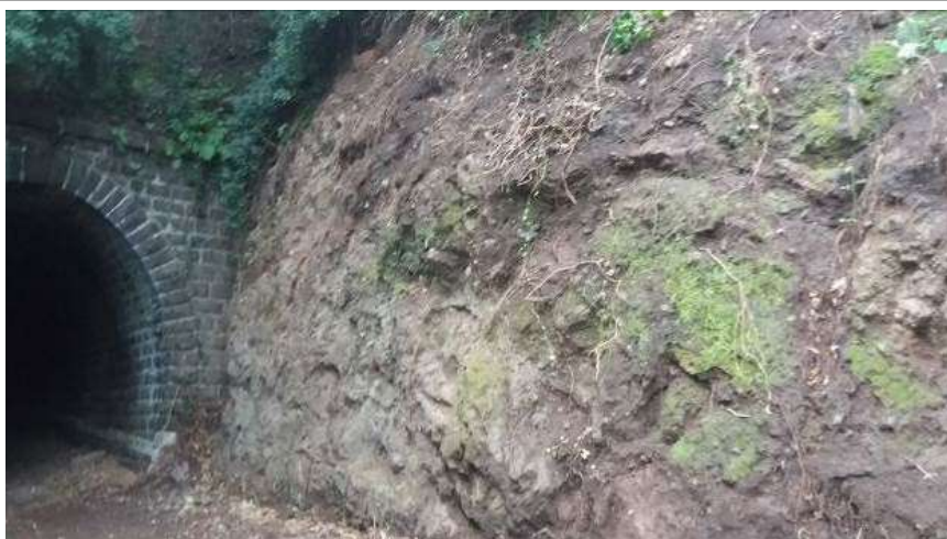
Foto 24 – Sezione di sbancamento dei depositi vulcanoclastici da Lahar sul vecchio tracciato ferroviario
