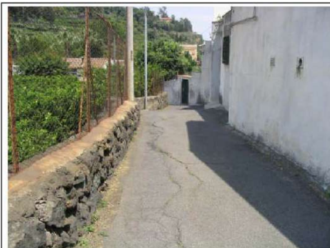
Foto 4 – Zona di frattura in corrispondenza di una stradina (via Pianetto) posta a Nord del Camping "Il Panorama" (Immagine del 20/06/2005).
