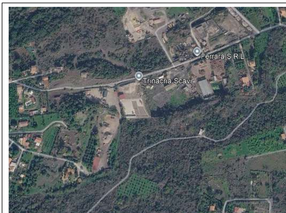
Foto 88 – Zona di cava dismessa e di accumulo inerti in zona via Pepetonazzo
