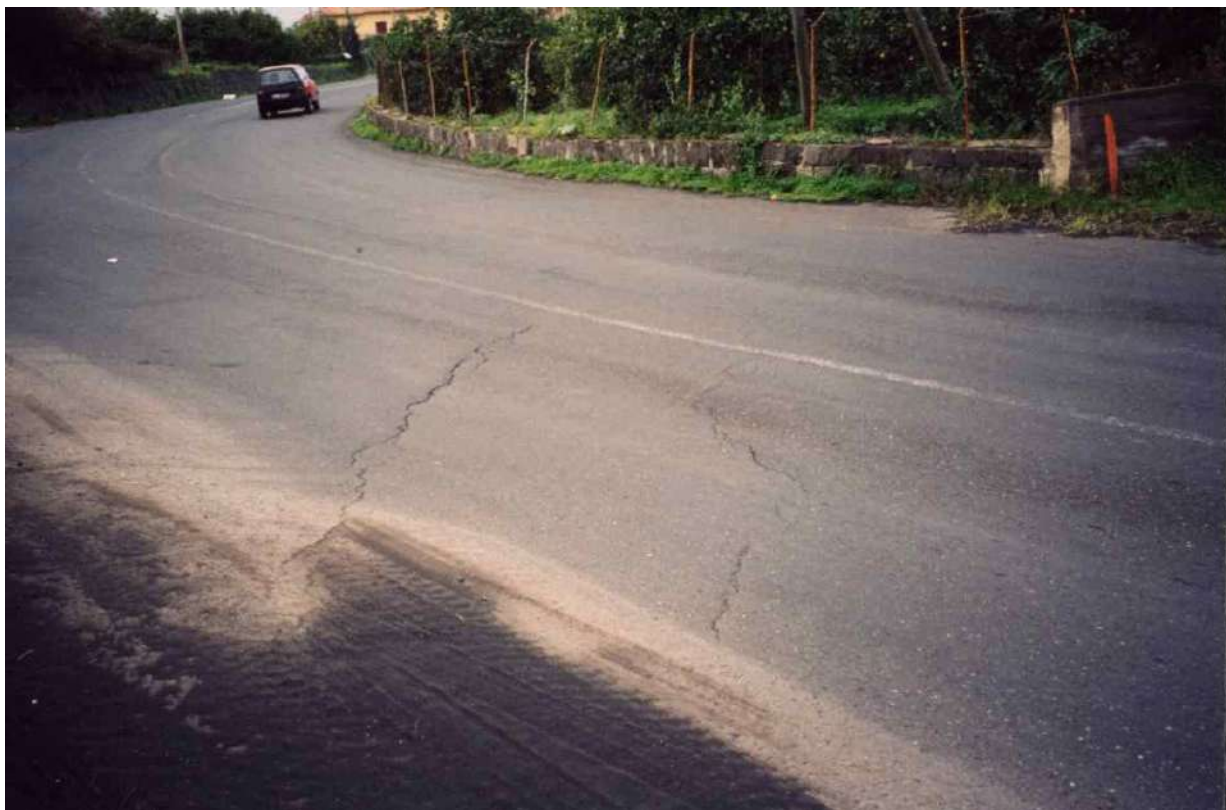
Foto 62 – Zona fratturazione terremoto del 29/10/2002 in via Palombaro
