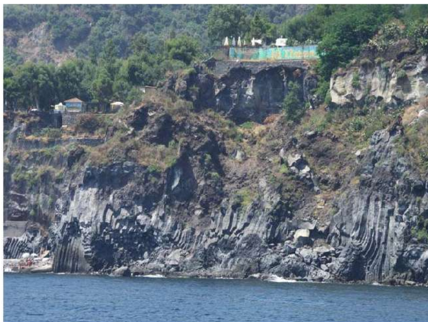
Grotta delle colombe. A sinistra bagnanti sulla spiaggetta 095-3AI-011
