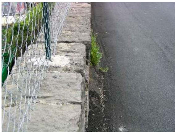
Foto 44 – Dislocazione con trasc. dx a Pozzillo
