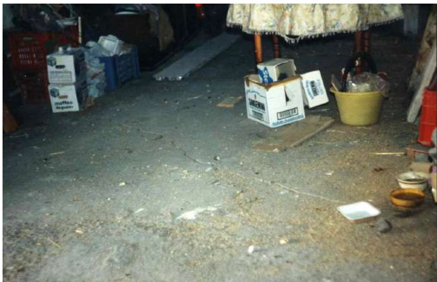
Fig. 1: Frattura in corrispondenza di un garage all'interno del centro abitato di San Giovanni Bosco (immagine del Maggio 1993).
