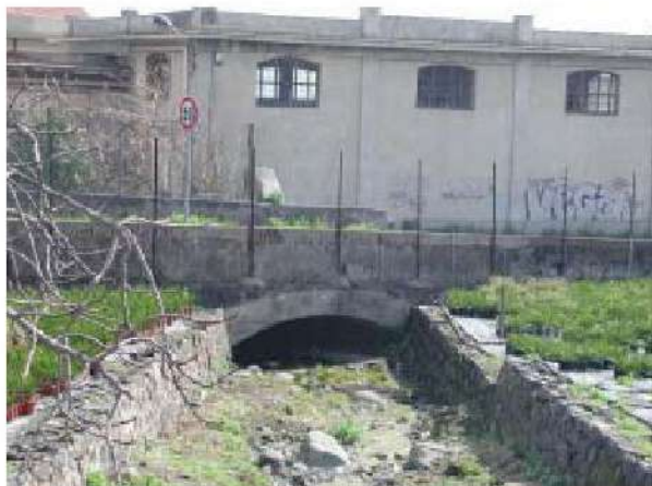
Fig. 4.3.24 – Torrente Peschiera: attraversamento S.S. 114.
