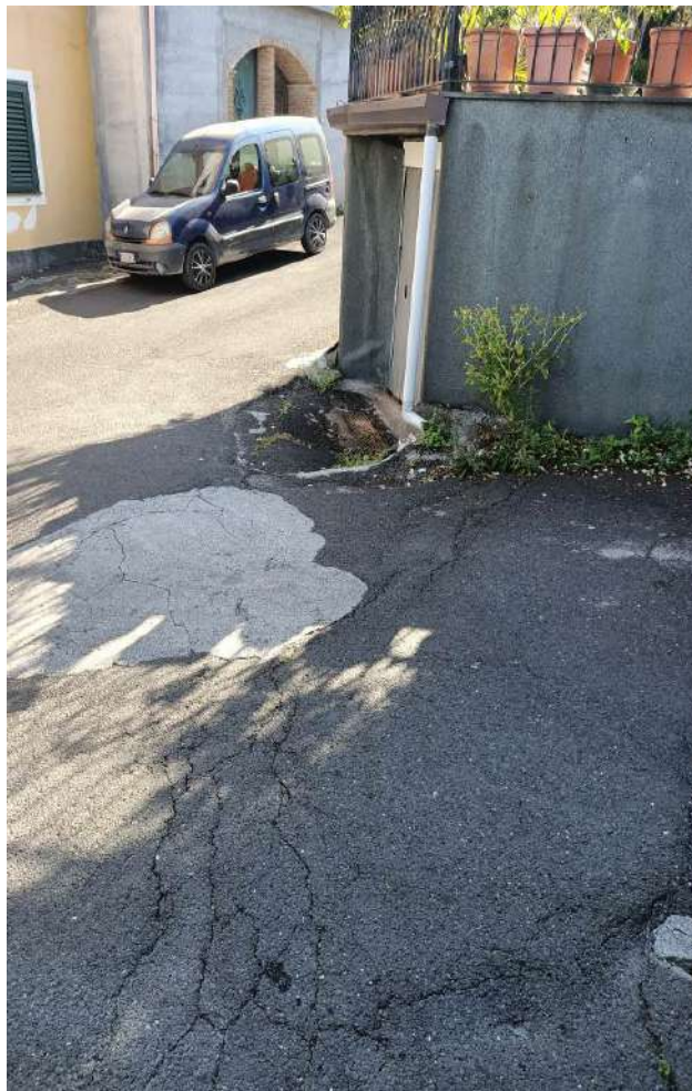
Foto.52 Fratturazione al suolo nella Faglia Vallone Pozzillo 3 in via Isnello
