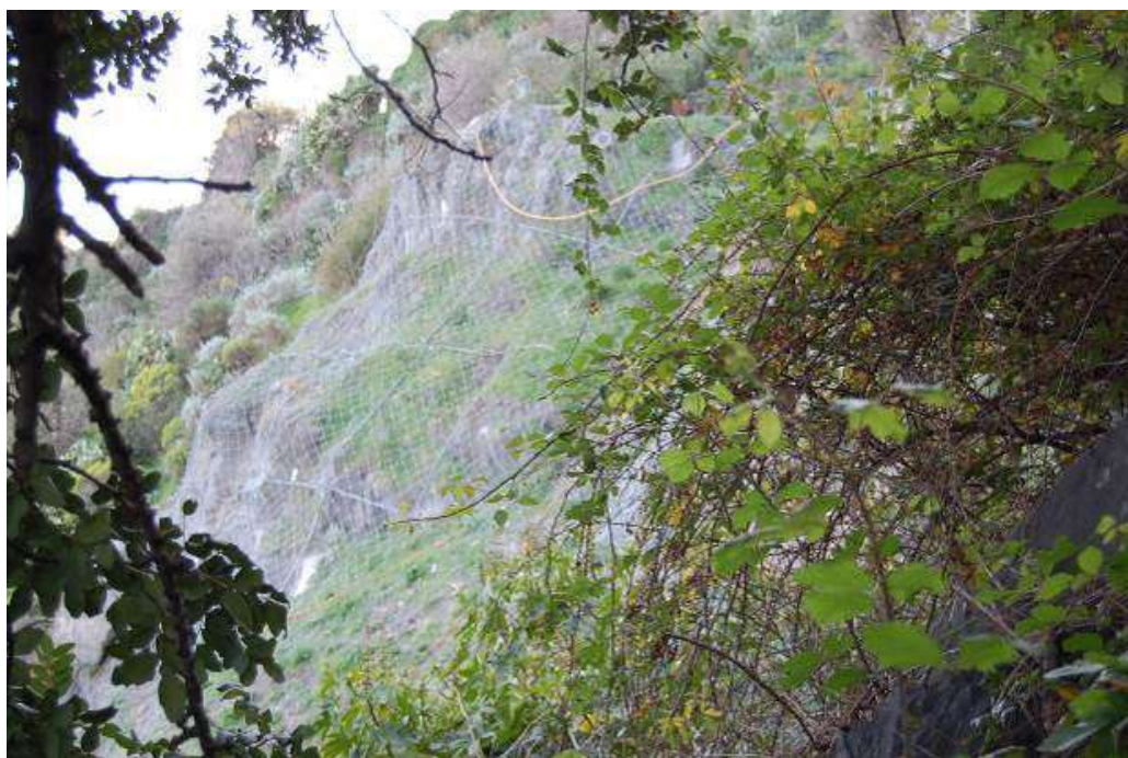
Foto 99: Scarpata della Timpa in Zona Santa Caterina: opere di consolidamento sul sentiero
