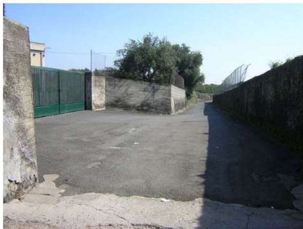
Fig. 4.3.21 – Torrente Platani: l'accesso a strutture produttive è l'alveo del torrente.
