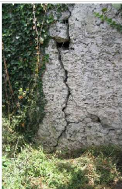
Foto 7 – Frattura lungo il muro di delimitazione dei terreni agricoli posti a Sud di Aciplatani (Immagine del 19/07/2005).
