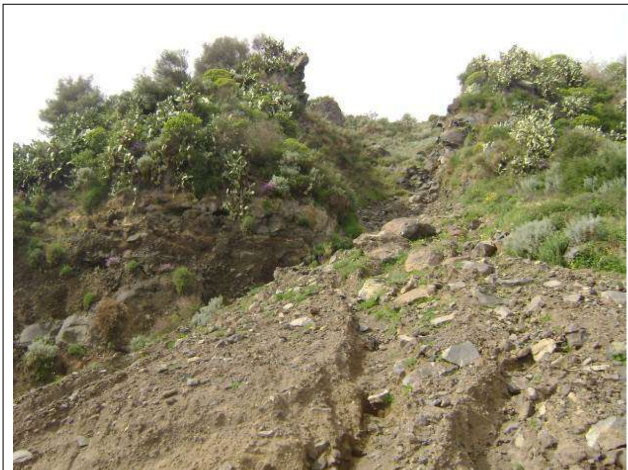
Foto 82– Zona di distacco e corpo di frana di detrito
