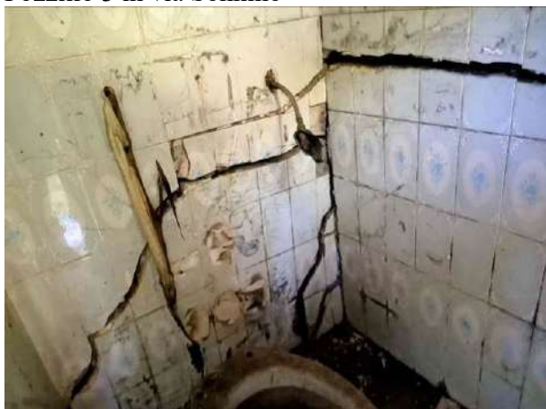
Foto 51 Fratturazione al suolo nella Faglia Vallone Pozzillo 3 in via Isnello
