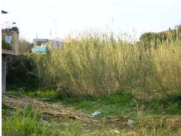
Fig. 4.3.18 – Torrente Platani: tombino in corrispondenza della S.S. 114.
